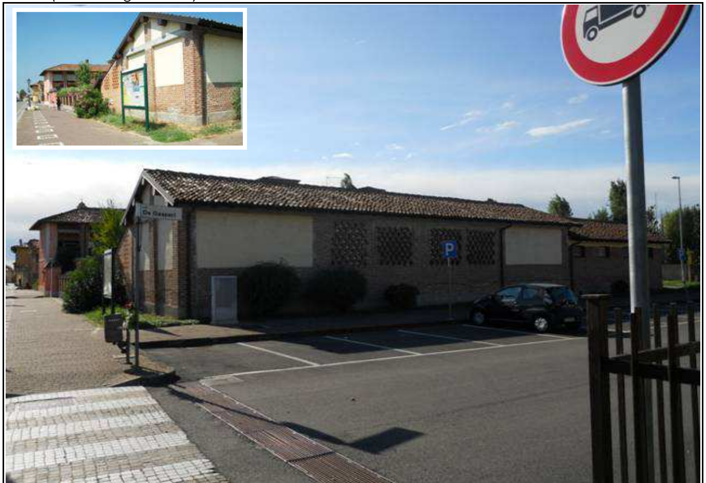
Foto a (con dettaglio Foto d)
