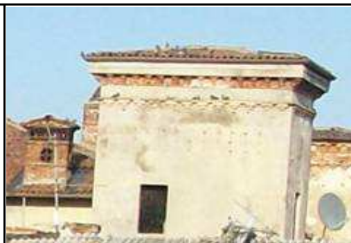
sopra: torre e tecnologie
